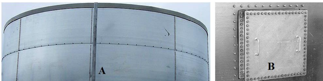
Figura 2.18 – Biorreator e detalhe. Construído em chapas de aço galvanizadas. (Disponível em http://www.iit.ie ).
