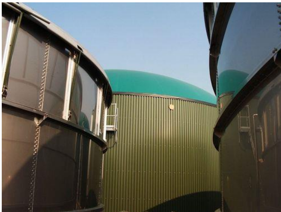
Figura 2.16 – Biorreatores anaeróbios construídos em chapas de aço. (Disponível em www.weltec-biopower.de ).
