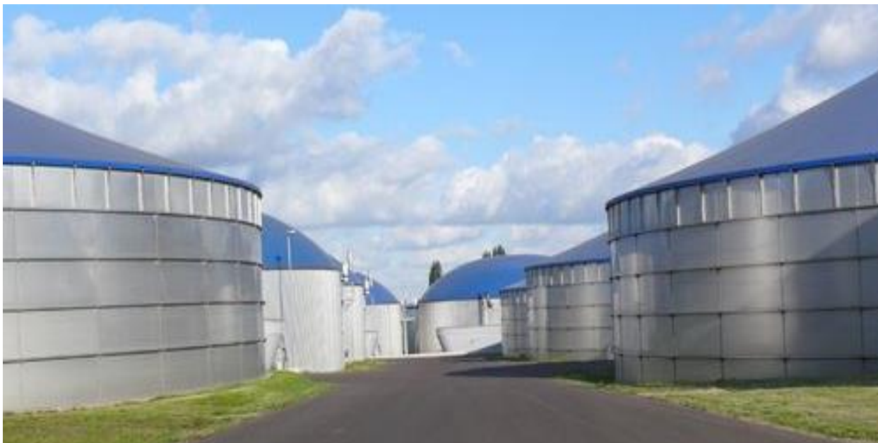
Figura 2.17 – Biorreatores anaeróbios em planta de biogás em Arneburg na Alemanha. (Disponível em www.weltec-biopower.de ).
