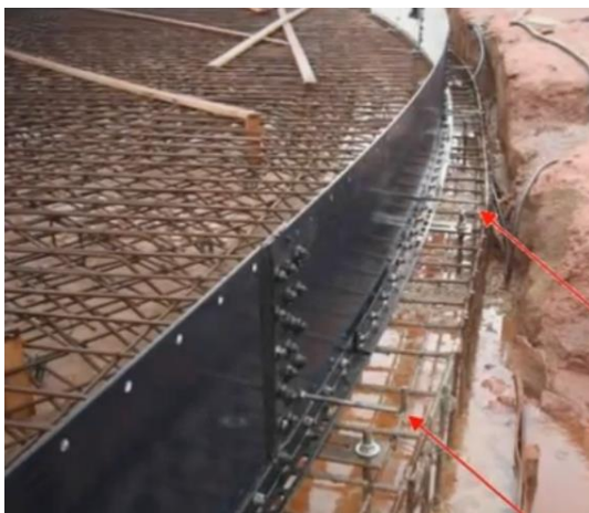
Figura 4.48 – Detalhe do posicionamento do primeiro anel.
