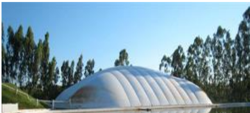
Figura 2.9 – Biorreatores de lona de PVC para tratamento de dejetos de suínos Disponível em ( http://www.sansuy.com ).
