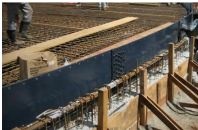
Figura 4.50 – Concretagem da base.
