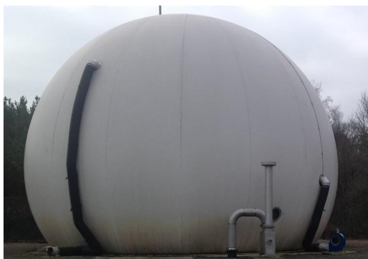
Figura 2.10 – Gasômetro para armazenagem de biogás (SCHULTE, 2013).
