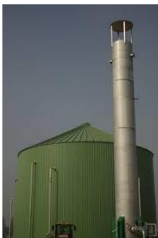
Figura 9.76 – Queimador de biogás. Disponível em www.hofstetter-uwat.com .
