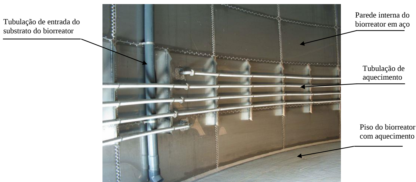
Figura 3.26 – Biorreator com aquecimento na parede e piso (SOUZA, 2010).
