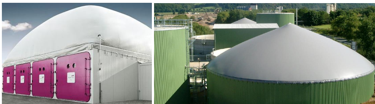
Figura 2.11 – Gasômetros integrados aos biorreatores (SCHULTE, 2013).
