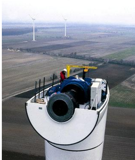
Figura 1 ( Manutenção de um aerogerador). [3]
